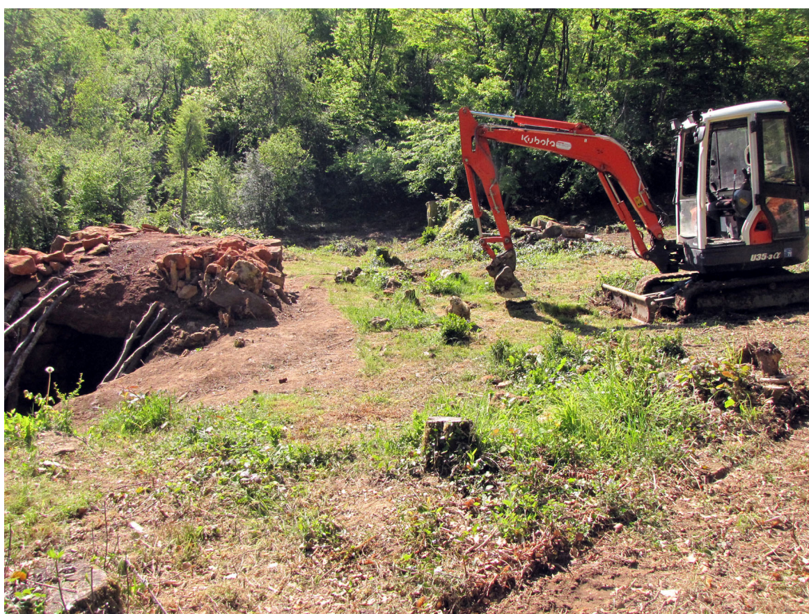
Illustration 5 : Vue générale, depuis le nord-ouest de la halle et du four de fusion au moment de leur dégagement
